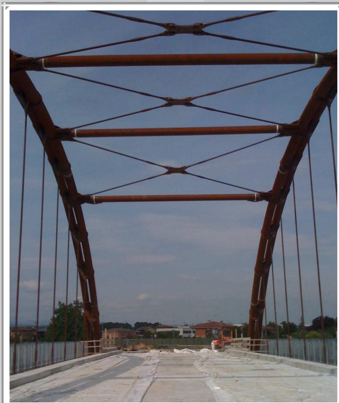
Completamento tangenziale sud nel tratto tra il torrente Rovacchia e l'incrocio di Cabriolo
