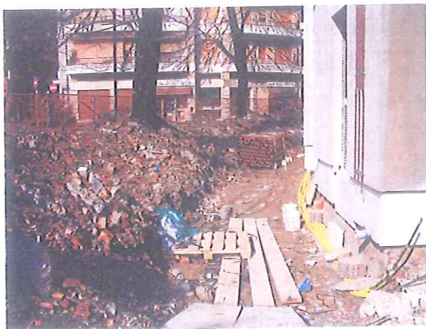
Foto n. 6: dettaglio del tipo di scavo eseguito che sembra essere stato ripetuto su tutta la superficie del cortile.
