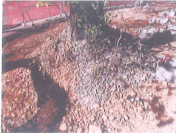
Foto n.16: dettaglio della zolla radicale residua.
